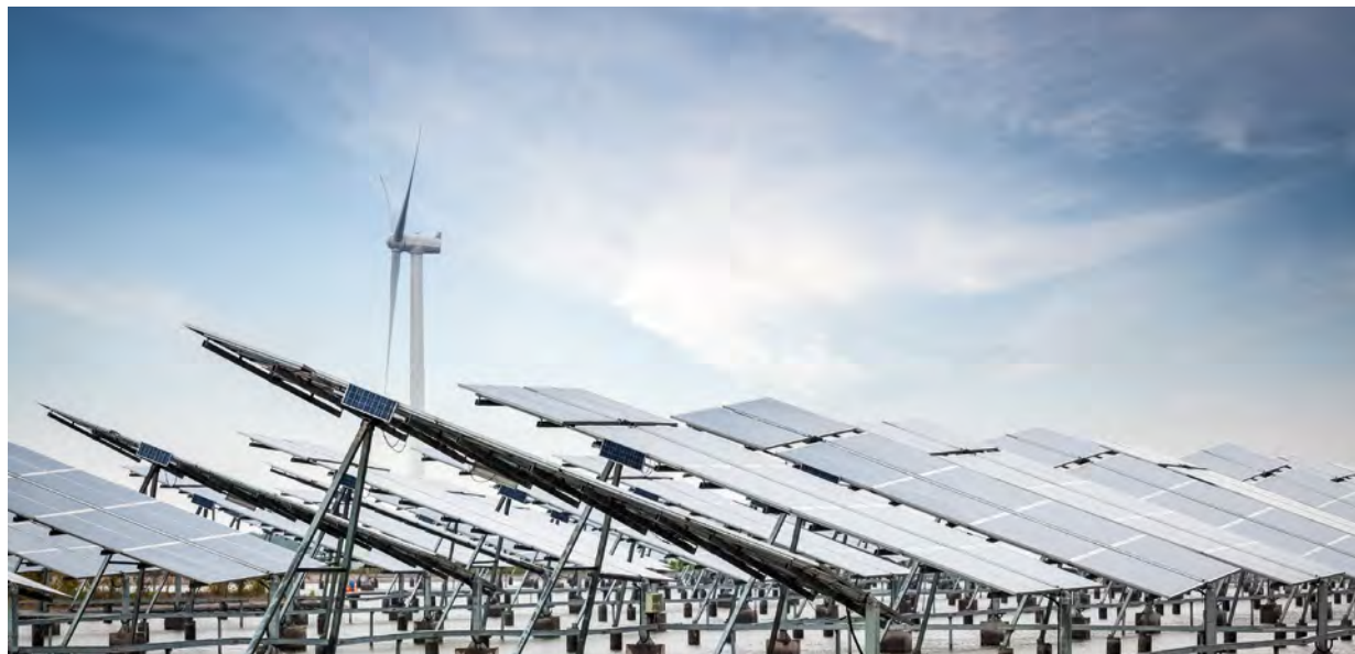
Hohe Strompreise, Windräder und Photovoltaikanlagen lassen viele Menschen mit der Energiewende hadern. (Foto: ©chungking – Fotolia)
